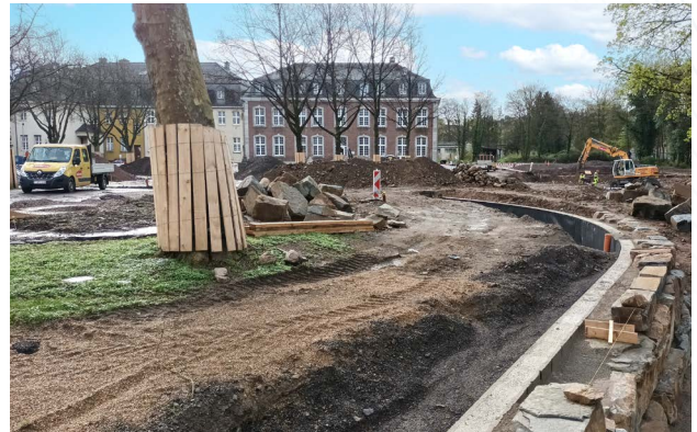
Bei Scheiblerpark und Hillstraße 1-7 befinden sich städtische Projekte im Tief- und Hochbau in direkter Nachbarschaft zueinander.
